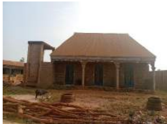
Construction en brique a Olorun shogo
